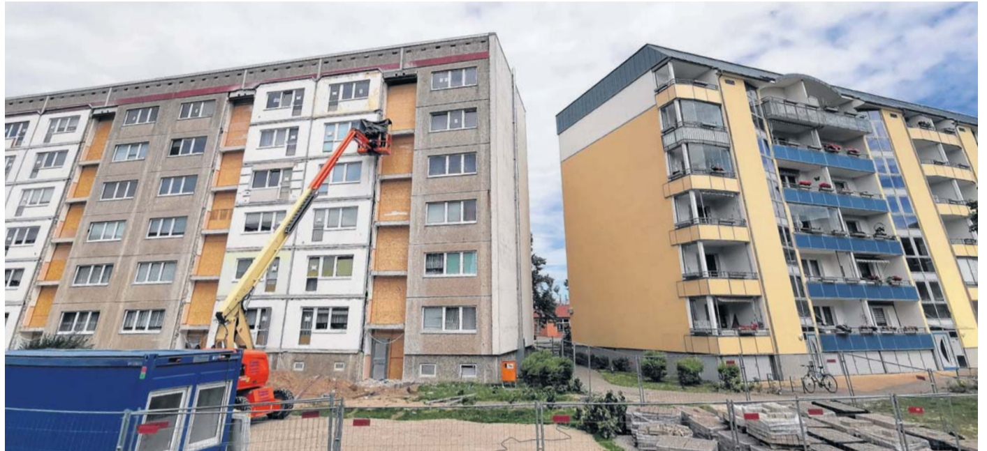
Im Hinterhof des Hamburger Rings wird derzeit tüchtig gebaut.
