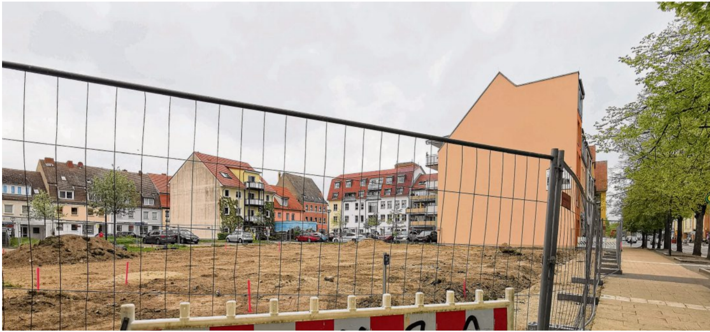
Auf der Baustelle haben in dieser Woche die Erdarbeiten begonnen.
