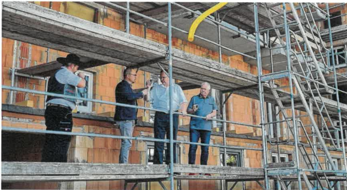
Nach dem zünftigen Richtspruch von Dachdeckermeister Enrico Korinth tranken AWG-Chef Falko Jonas, Bürgermeister Michael Galander und der stellvertretende Aufsichtsratsvorsitzende Jörg Schröder (v.l.nr.) traditionell auf die fleißigen Handwerker in der Keilstraße.
