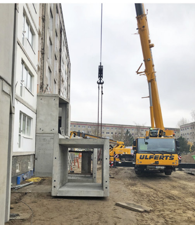
Unten: Ein Element für den Fahrstuhlschacht. (Foto: WGA)
